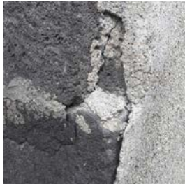
Moellons de trachy-andésite grise + mortier de chaux
