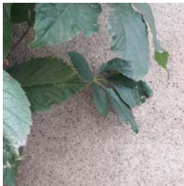
Ciment (et brique ?)
