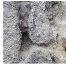
Moellons de trachy-andésite grise + mortier de chaux
