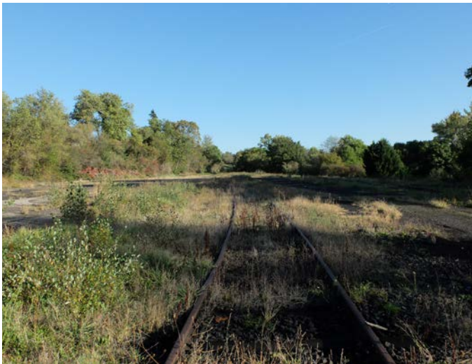
Photos de l'ancienne briqueterie, route de Clermont, Billom.
