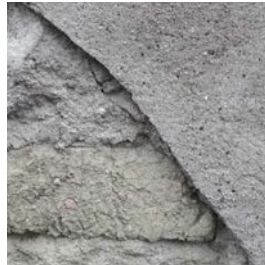
Moellons de trachy-andésite grise + mortier de chaux
