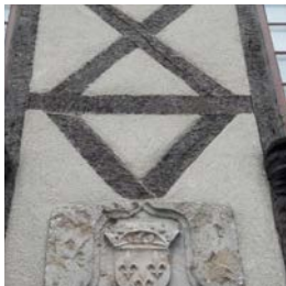
Maçonneries en colombages en étage
