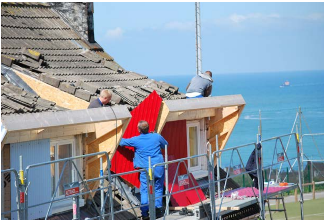
Fig. 40-43 Chantier de réhabilitation en permanence architecturale, Agence Construire, Boulogne-sur-Mer, 2010-2013.
