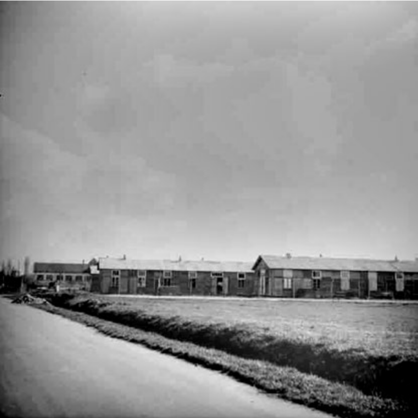
Constructions provisoires, cité des Groues, 26 septembre 1945.
