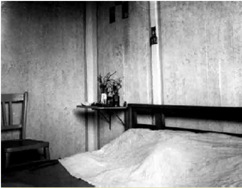
Constructions provisoires, cité des Groues, chambre avec lit,
