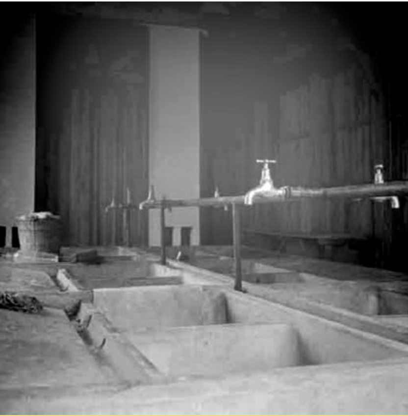
Constructions provisoires, cité des Groues, sanitaires collectifs.
