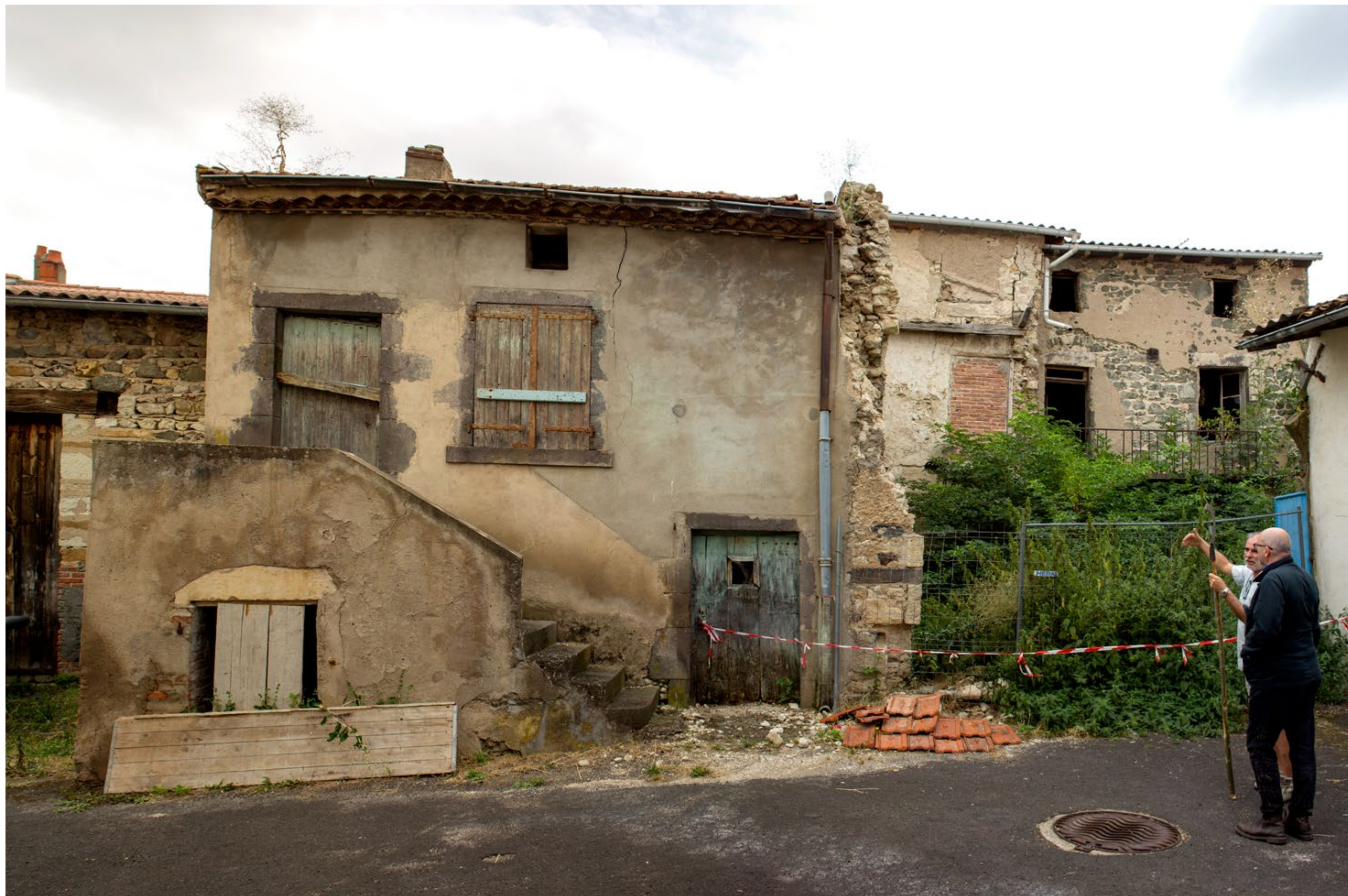
Centre bourg en cours de rénovation
