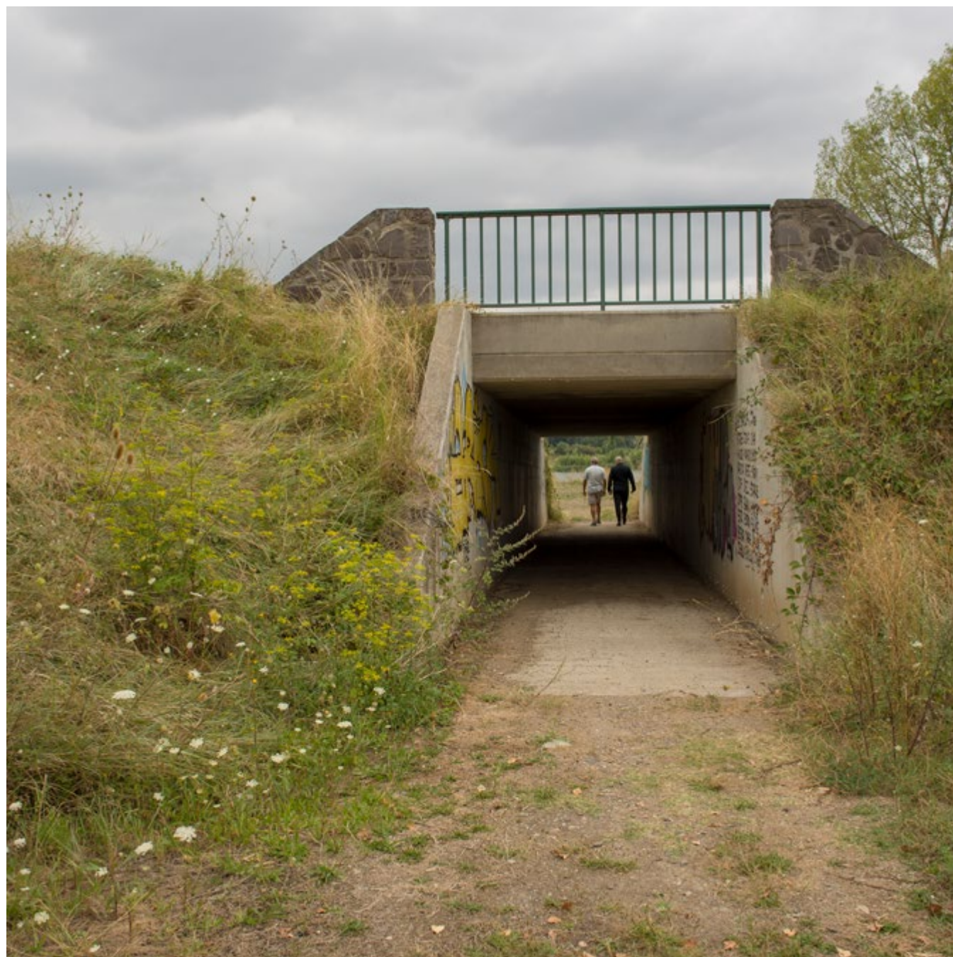
Le tunnel sous la route departementale 1
