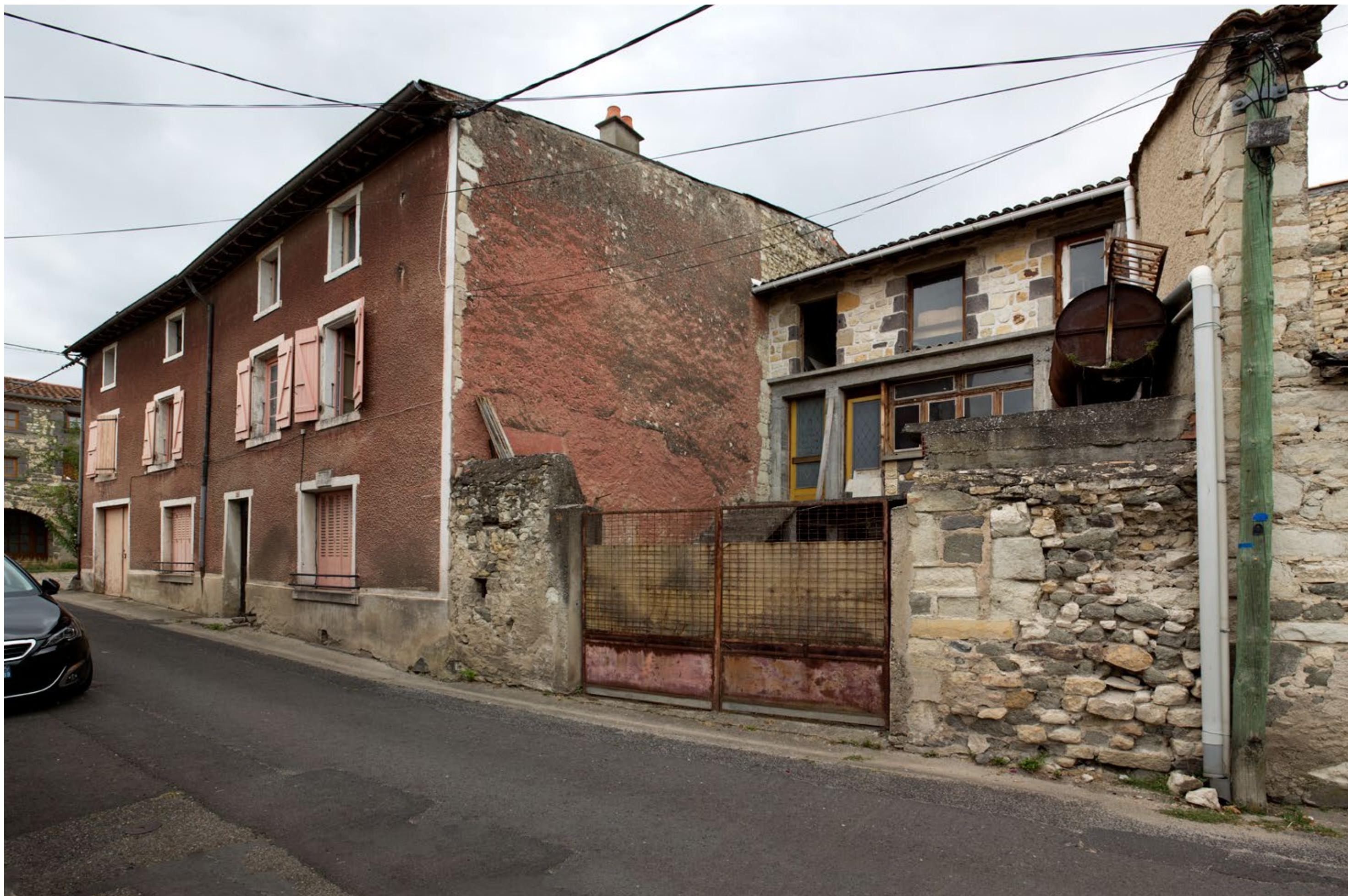
Centre bourg en cours de rénovation
